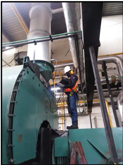
Fotos N°01 y N°02: Vista de Medición de Emisiones Atmosféricas en chimeneas de Caldera Cleaver (izquierda) y Caldera Distral (derecha)
